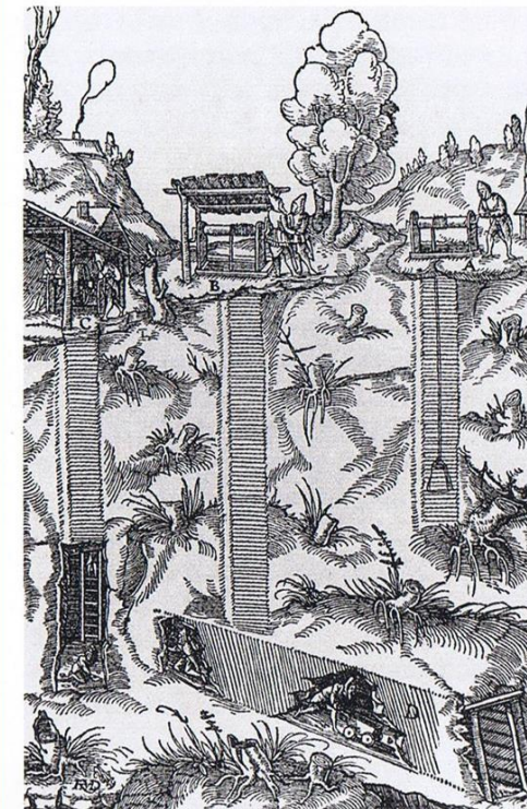
26. Puits d'extraction, à différents stades d'avancement, au milieu du XVI e siècle. Agricola, «De re metallica», 1556.
