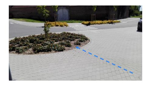
Parterres de plein pied afin de pourvoir infiltrer l'eau des zones imperméables en amont
