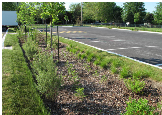
Figure 3: Bande filtrante le long d'une zone de parking - Source:
