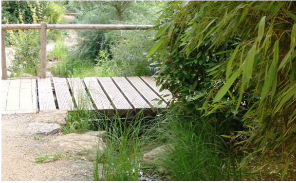
Figure 3: Petit fossé à berges en rochers et à fond de gravier. Lotissement Arkadien à Asperg (Stuttgart). Source photo: Valérie Mahaut
