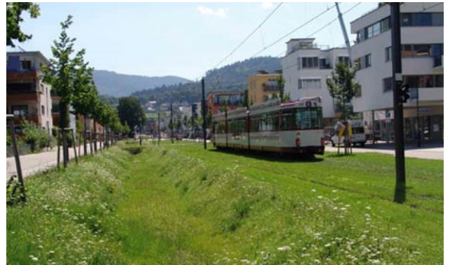
Figure 6: Noue en pente scindée en plusieurs biefs par des murets formant un barrage avec un dispositif de vidange dans le quartier du Kronsberg, Hanovre, Allemagne. Source photo: Valérie Mahaut
