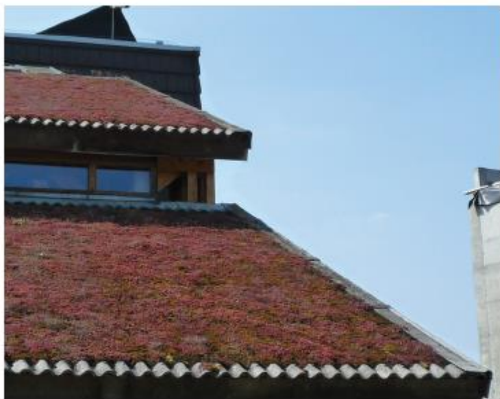
Figure 7: Toiture stockante végétalisée - semi-intensive sur le magasin Caméléon - Source: Catherine Massart
