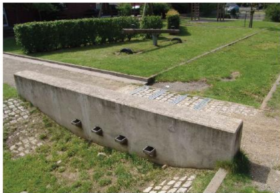
Figure 10: Noue infiltrante à revêtement pavé à joints non cimentés, barrée par un mur de soutènement reliant cette noue à la suivante par un dispositif de trop-plein. Quartier du Kronsberg, Hanovre. Source photo: Valérie Mahaut
