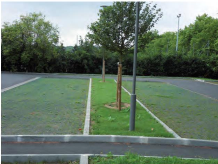
■ Parking à structure alvéolaire à Boussy-Saint-Antoine
