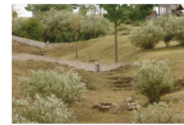
Figure 5: Noue en pente inclinée en planche boisée par des mursets formés en béton avec un dispositif de drainage dans le quartier de Koning, Harem, Allemagne. Source photo: Valérie Méreau
