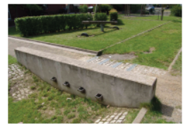
Figure 6: Noue infiltrante à revêtement boisé à joints non étanchés, bords en béton et revêtement boisé dans le quartier de Koning, Harem, Allemagne. Source photo: Valérie Méreau
