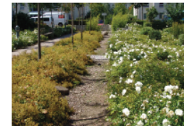
Figure 7: Noue infiltrante renforcée par revêtement planté. Quartier de Koning, Harem, Allemagne. Source photo: Valérie Méreau
