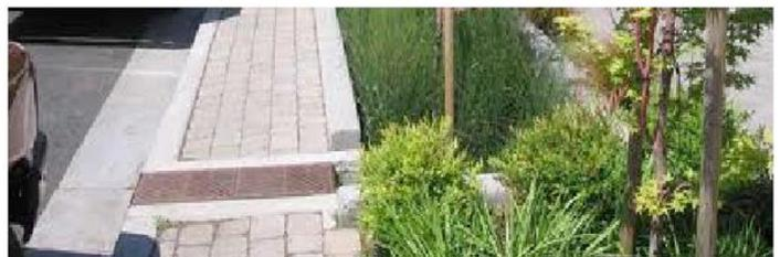
Figure 2: les fosses d'eau pluviale agissent comme de mini réservoirs au pied des arbres de pluie - Source: EPA, Stormwater to street tree - <https://www.epa.gov/sites/production/files/2015-11/documents/stormwater2streettrees.pdf>
