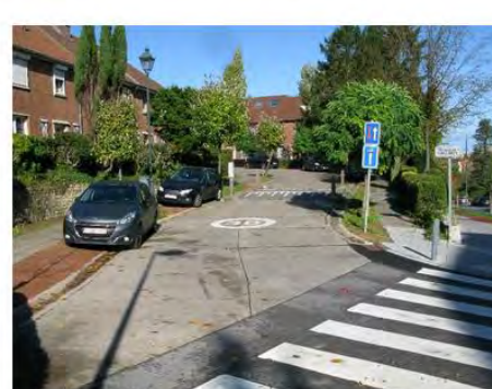
Accès à une zone 30 avec dispositif surélevé
