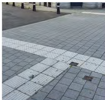
Accès à une zone 30 avec trottoir traversant
